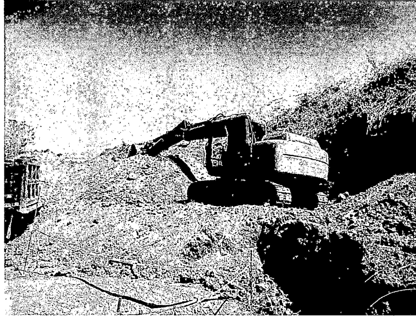
FOTO No.1 EXCAVACION DE HUMEDALES
