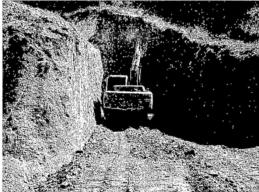
FOTO No.2 EXCAVACION HUMEDALES
